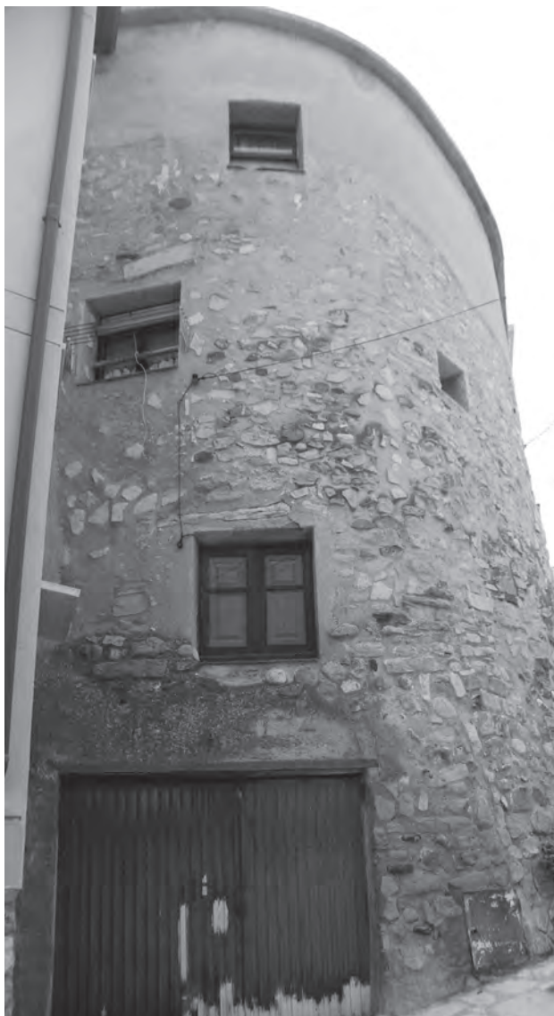
FIGURA 5: Construcció de planta circular al carrer de Dalt, que J. Felip identifica amb una torre de la muralla del segle XII
