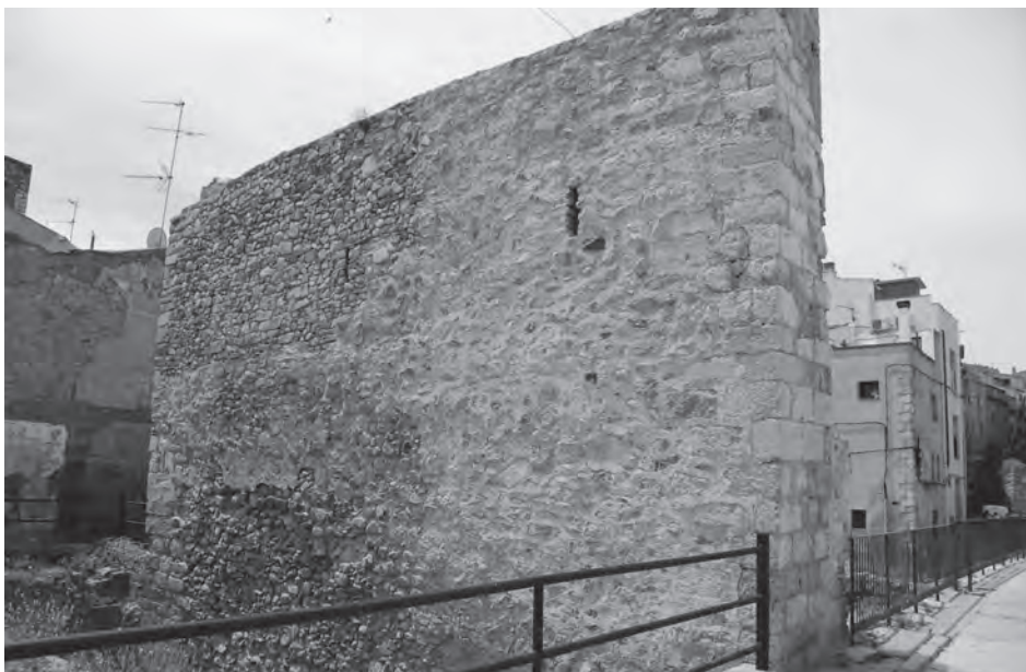
FIGURA 8: Restes de la casa del monestir de Poblet, al costat del carrer Riuot. En construir-se la muralla del segle XIV, aquest edifici es va integrar en el sistema defensiu
