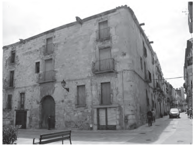
FIGURA 17: Cal Carlà, edifici vinculable als epígons del gòtic i inicis del renaixement alla italiana
